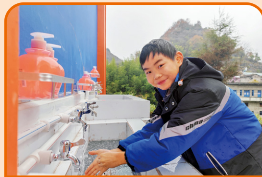
小桥微笑着在新建的洗手台洗手，严格按照刚学的七步洗手法洗手。
